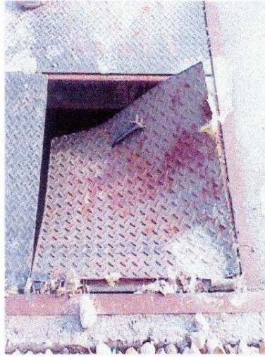
【水密性のない金属蓋】 【水密性のないコンクリート羽目板】 (出典：ICTP 2007年ワークショップ資料)
