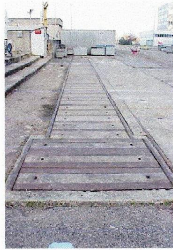
【水密性のない金属蓋】 【水密性のないコンクリート羽目板】 (出典：ICTP 2007年ワークショップ資料)
