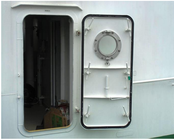
図6 船舶の甲板上入口に設置された水密扉
