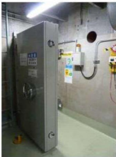
旧水密扉を撤去し、新しい水密扉を取り付けた例
