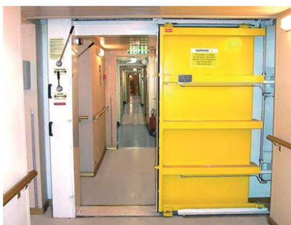
図5 船舶の水密隔壁に設置された油圧式水密扉
